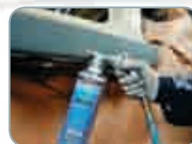
Защита от коррозии
